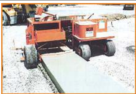
Bordsteinfertigung mit Rinnstein
